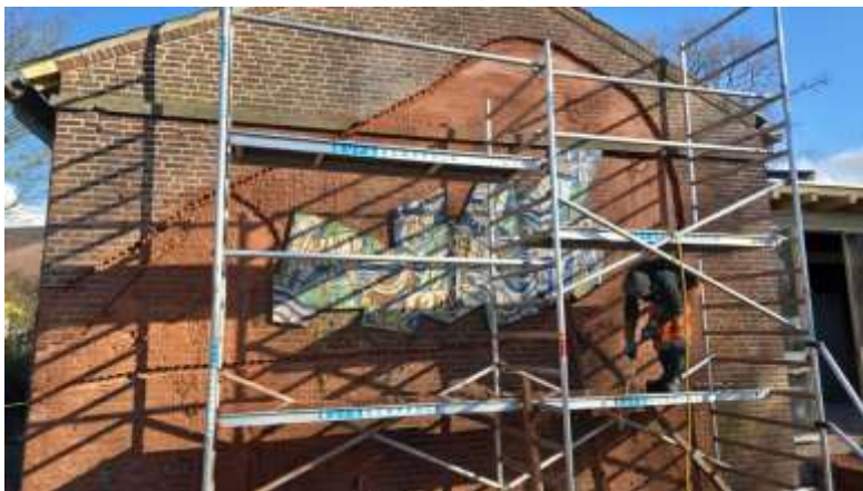
Ontmanteling gevelplastiek J.B. Lambert Simon, Lammenschansweg 4-6 (foto: Peter Lamboo)
