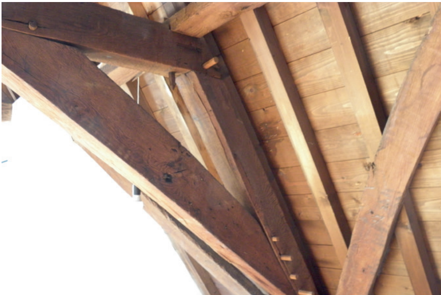
Indrukwekkende balkenlaag met houten pennen.
