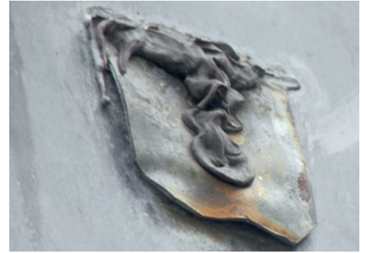
De meest voorkomende methode om inwateren te voorkomen; de zinken trotseerder
