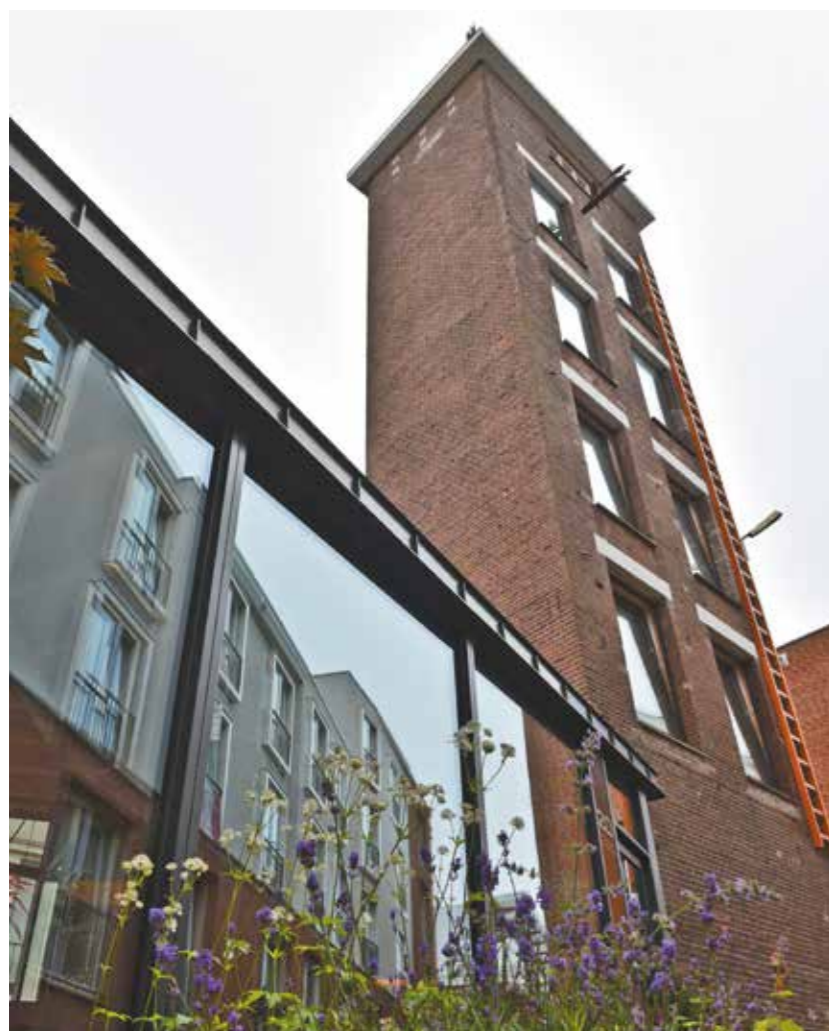
De brandslangendroogtoren met links de moderne uitbouw.
