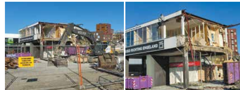
De sloop van het pand van Zierikzee aan de Lammenschansweg 138.
