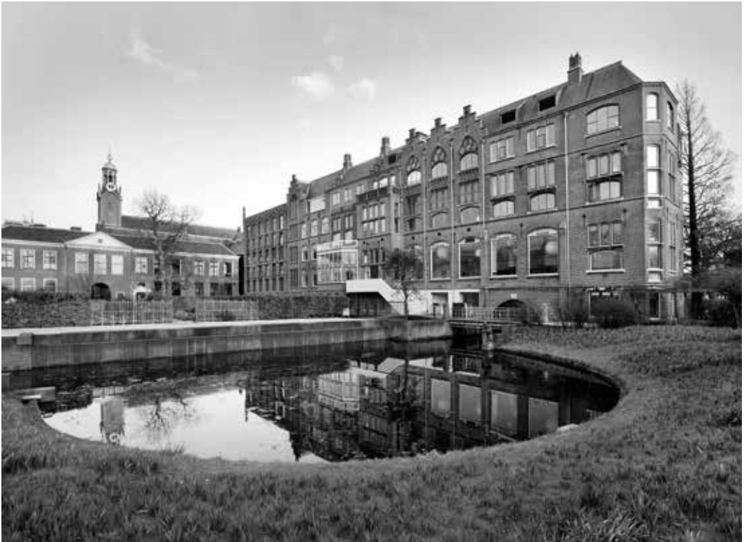
P.J. Vethgebouw in 2017 gerenoveerd voor geesteswetenschappen. Gebouwd in 1904-1906 als botanisch laboratorium en Rijksherbarium.
