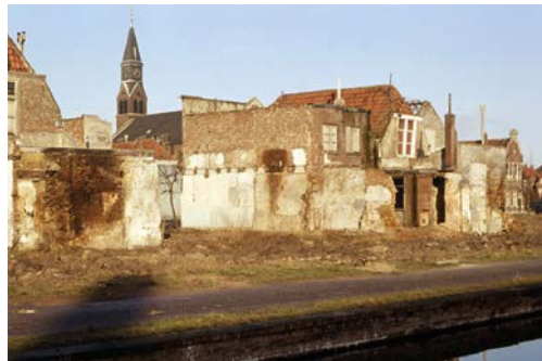
Sloop aan de Oranjestraat (fotograaf: H. Groenewold).
