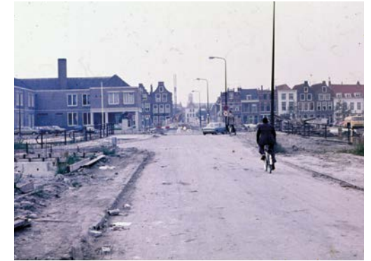
De Oosterkerkstraat met gesloopte huizen en de nieuwbouw van het huisartsencentrum en de apotheek (foto: gemeente Leiden).
