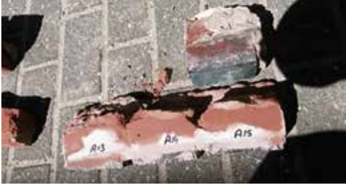
De delen van het gevelement zijn gemarkeerd, zodat ze later weer samengevoegd kunnen worden (foto: Jan Hartstra).
