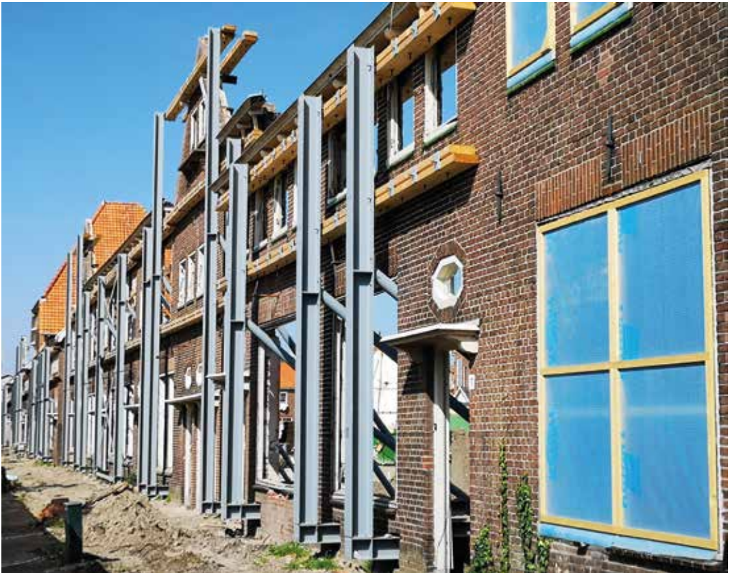
Tijdelijke staalconstructie om voorgevel te behouden (foto: Wouter Fokkinga).
