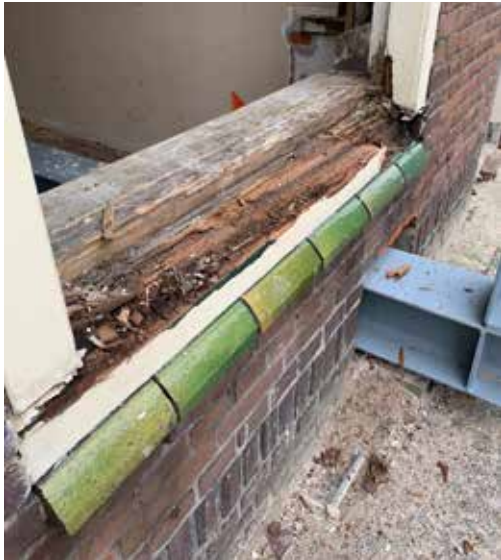
Oorspronkelijke groen geglazuurde raamdorpelstenen (foto: Gert Jan te Velde; Vanschagen Architecten).
