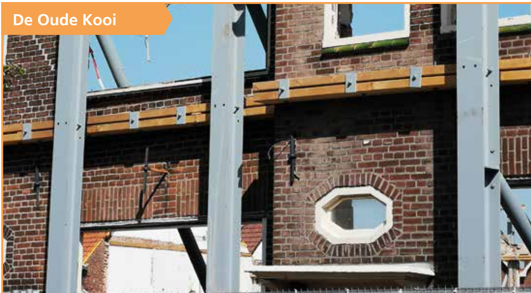
Staal- en houtwerk ten behoeve van behoud van de voorgevel van de Centrale Blokken van de Oude Kooi (foto: Wouter Fokkinga).
