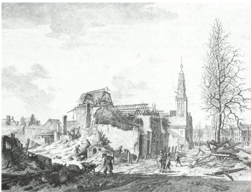
Reddings- en opruimwerkzaamheden aan het Steenschuur. L. Overbeek, Verwoesting op het Rapenburg te Leyden, 1807.
