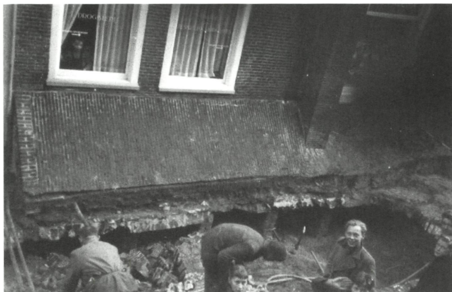
De afbraak van de overkluizing van de Langebrug ter hoogte van Diefsteeg 9, 1956.
