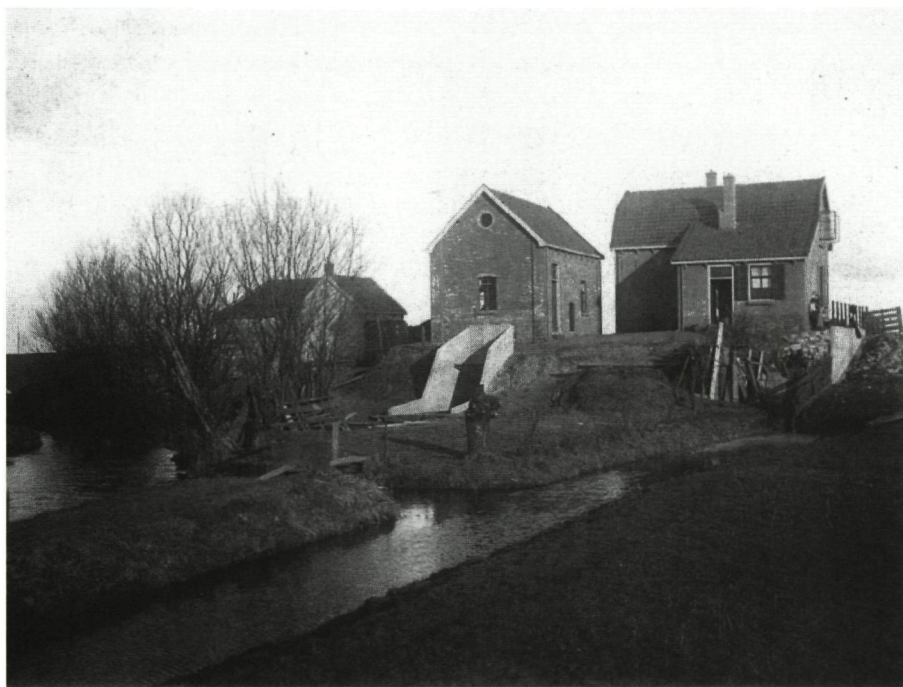
Het gemaal dat in 1924 op de plek van de molen werd gebouwd, met rechts de woning van de machinist.
