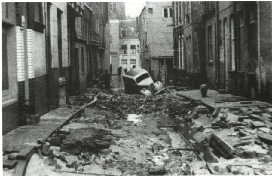
De Sarazijnstraat in Vliissingen nadat het water is weggelopen. Coll. Gemeentearchief Vliissingen.
