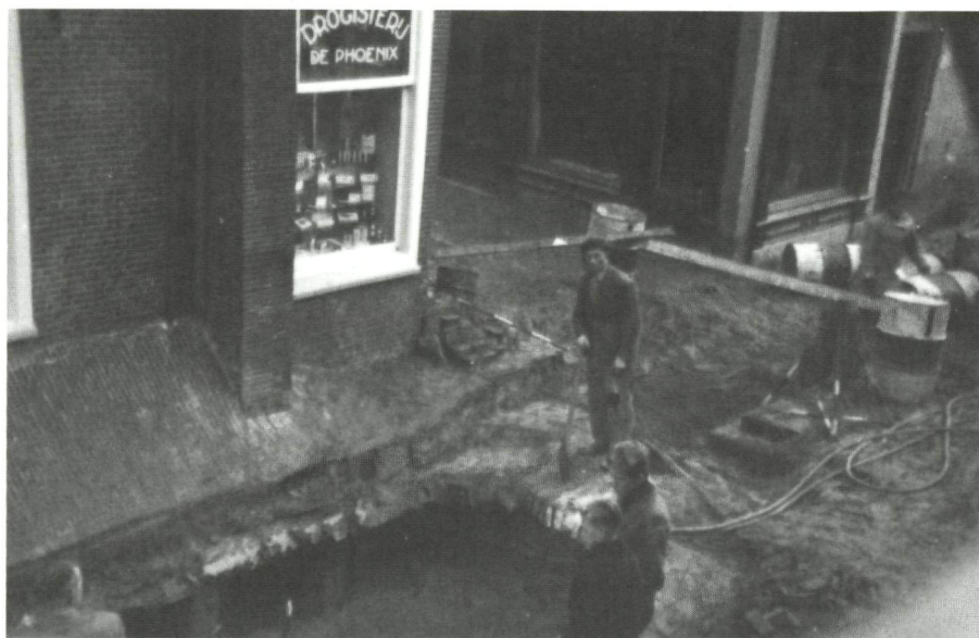
De afbraak van de overkluizing van de Langebrug ter hoogte van de Diefsteeg, 1956.
