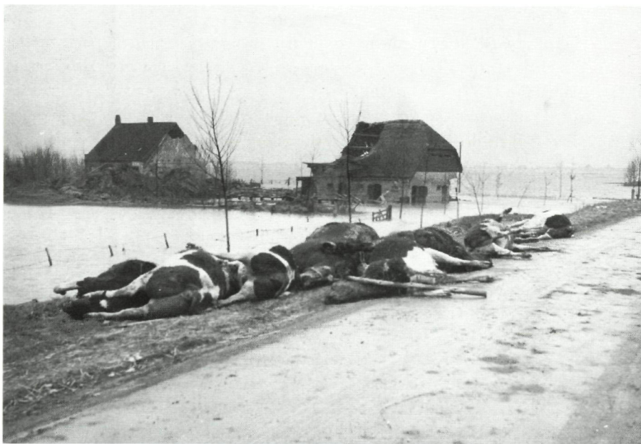
Verdronken koeien op de Battenoordse Dijk in Nieuwe Tonge. Foto door A. van Vliet, 1953. Coll. Streekarchief Goeree-Overflakkee.
