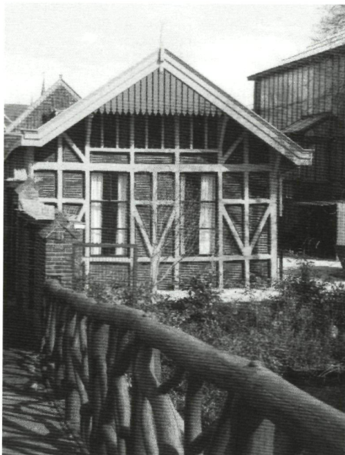
De vakwerkschuur na de restauratie.
