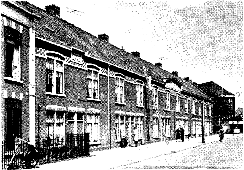
afb. 8. Woningen aan de Rijsburgersingel, gebouwd door de Leidse Bouwvereniging naar een ontwerp van W.C. Mulder ± 1955. Foto Gemeentelijke Archiefdienst, Leiden.
