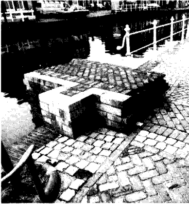
afb. 8. Opmetseling oude vestmuur aan de Oude Rijn.
