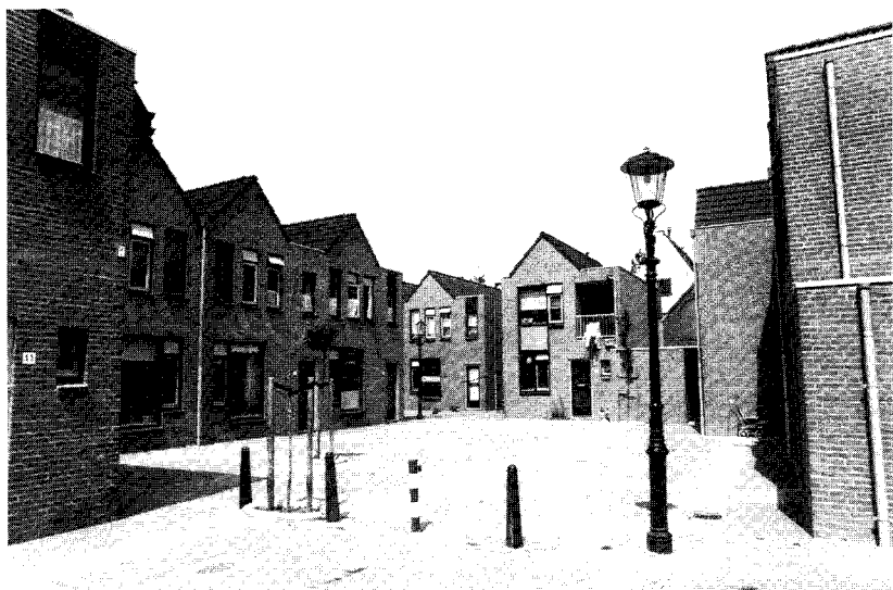
afb. 7. Nieuwbouw aan de Mirakelsteeg.
