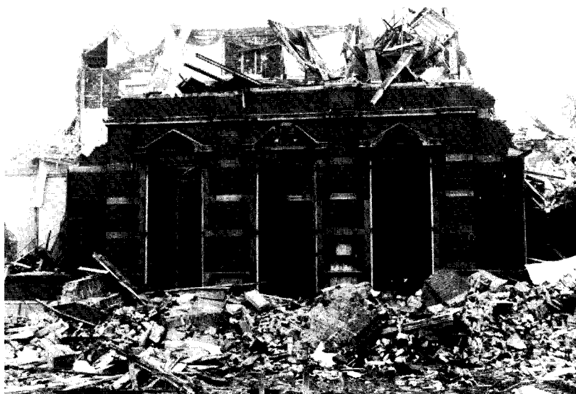
afb. 79. De voorgevel van Nieuw Rijksdorp tijdens de sloop, 19 januari 1984. Foto Robert van Lit.
