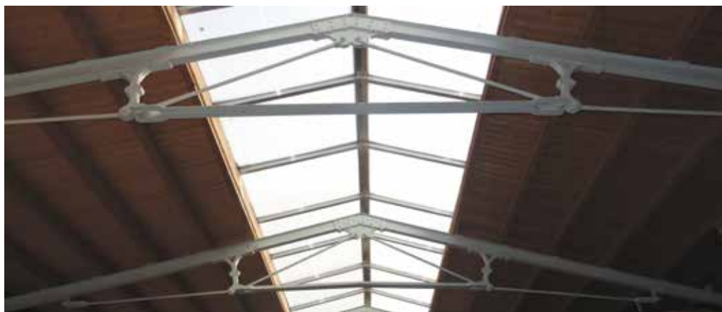
Polonceauspanten in de voormalige machinefabriek aan de Rotterdamseweg in Delft, 2022. Foto: Erfgoed Leiden en Omstreken.
