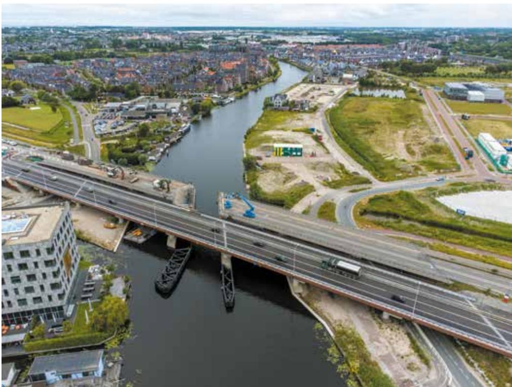
13 juli De nieuwe Torenvlietbrug tussen Leiden en Valkenburg. Foto: Hielco Kuipers
