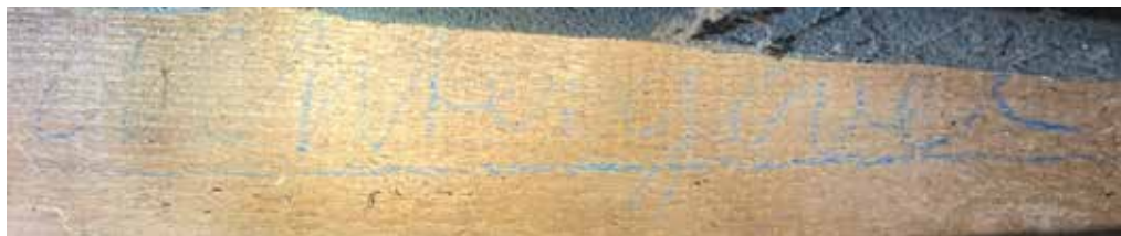
De bouwhistorici van Erfgoed Leiden en Omstreken vonden in Kernstraat 9 op verschillende houten planken en balken aanduidingen geschreven in blauw krijt. Boven: houten plank met het jaartal 1920. Onder: onderzijde van de bovenste balk van de achtergevel, met het woord 'achtergevel'.
