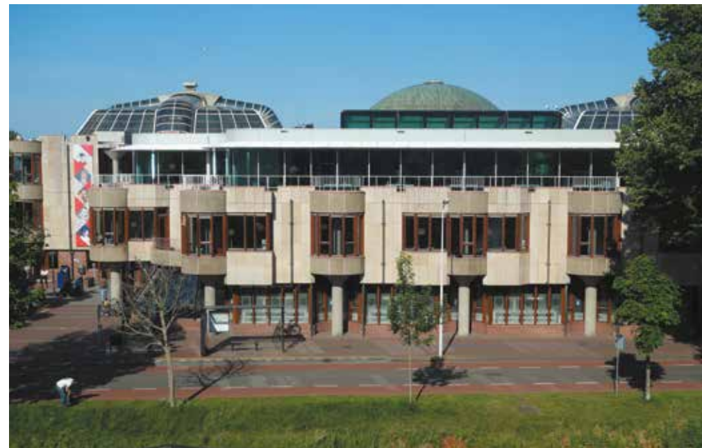
De Leidse universiteitsbibliotheek aan de Witte Singel, een ontwerp van Bart van Kasteel (1978-1984). De afstand tussen de paddenstoelkolommen vormt de modulemaat die zowel de plattegrond als de gevelindeling bepaalt. Foto: Erfgoed Leiden en Omstreken.
