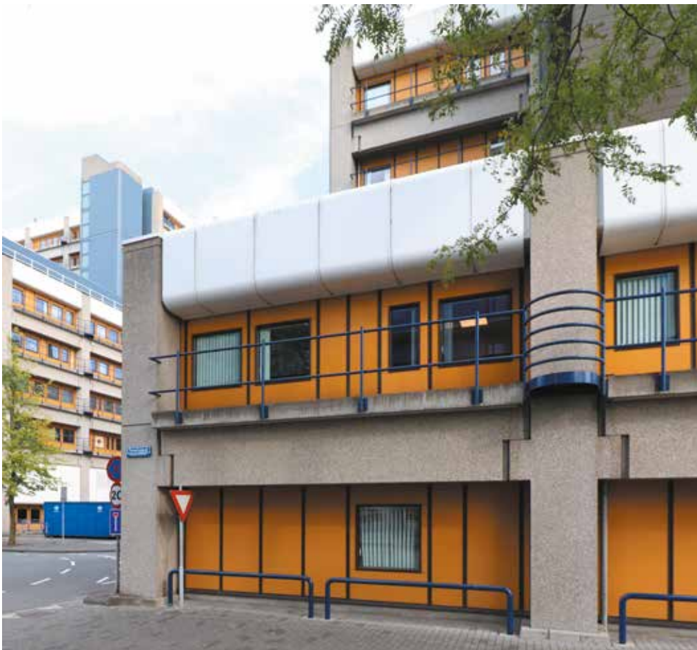
Het Leids Universitair Medisch Centrum is naar ontwerp van B & D Architecten tussen 1980 en 1985 gebouwd aan de Albinusdreef. Het heeft een voor die tijd kenmerkende structuralistische architectuur en een typerend kleur- en materiaalgebruik. Foto: Erfgoed Leiden en Omstreken.
