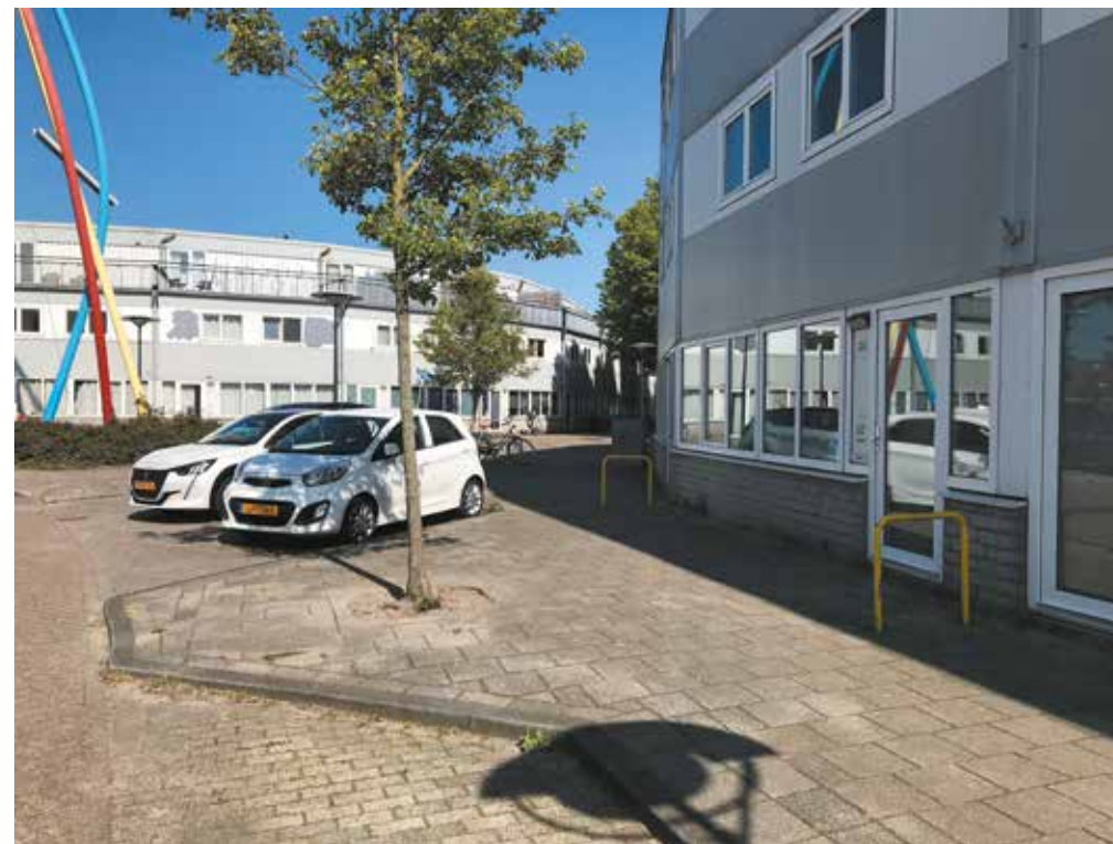
Stalen woningen rond de Margaret Staalstraat, ontworpen door architect Fons Verheijen (1987-1989). Foto: Erfgoed Leiden en Omstreken.
