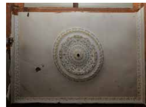
Cassette van het plafond in Breestraat 128 met ornament in het midden en gedecoreerde lijsten, alles van papierstuc. Foto: Erfgoed Leiden en Omstreken.
