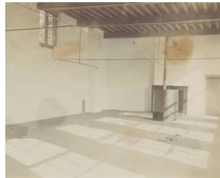
De nog steeds bestaande voormalige ziekenzaal voor pestlijders in het Ceciliaagasthuis (het huidige Rijksmuseum Boerhaave). Tegen de wanden stonden bedsteden. De hooggeplaatste ramen waren bedoeld om de zaal goed te kunnen ventileren, tegen – volgens de medische leer van die dagen – ziekmakende bedorven lucht. Foto vermoedelijk 1955-1960. Collectie Rijksmuseum Boerhaave, Leiden.
