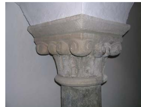
Kapiteel van de hergebruikte zuil, gehouwen uit Norroy kalksteen. Het van oorsprong Romeinse kapiteel is in de dertiende eeuw bijgewerkt in een voor die tijd moderne, romaanse vormgeving. De zuilschacht werd vervaardigd van groen leucietofier uit de Eifel. Foto: Edwin Orsel.
