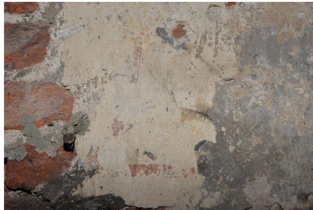
De restanten van een muurschildering in het oorspronkelijke achterhuis van Pieterskerk-choorsteeg 15. Het gaat om de rode strepen in de vorm van een L en om de gele 'vlekken' op de kalkpleister. Foto: Edwin Orsel.
